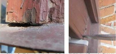
Abbildung 3: Werkzeug kann mit geringem Kraftaufwand in Holz eingestoßen werden, Fäulnis ist auf kleine Bereiche (z. B. Schlagleiste unten) beschränkt. Bild links: Kugellager sind grundsätzlich zu vermeiden, in diesem Fall wird empfohlen die neue Schlagleiste kürzer auszuführen
