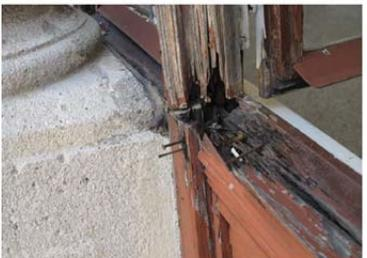
Abbildung 4: Werkzeug kann mit geringem Kraftaufwand in Holz eingestoßen werden, Fäulnis umfasst große Bereiche
